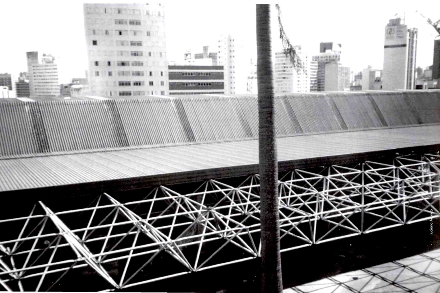
Viaduto Miguel Vicente Cury . Terminal Central 2001
