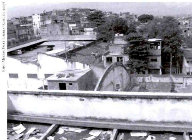
Figura 5 – Complexo da Maré, ocupação de galpão industrial próximo à av. Brasil.
