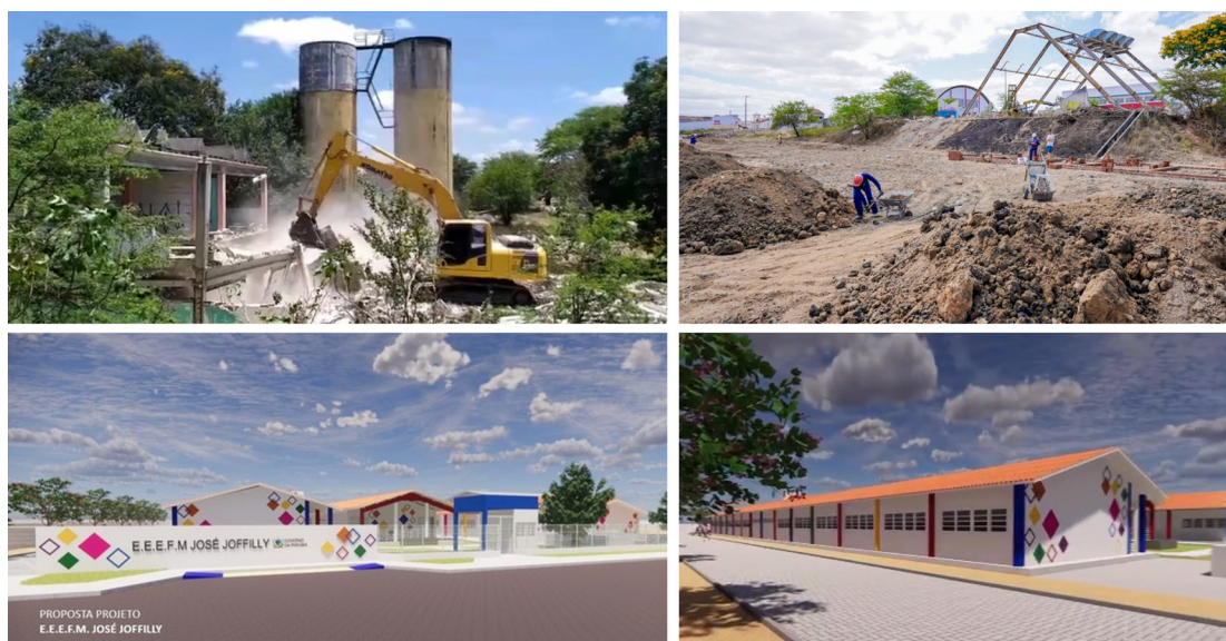
Figura 10 – Acima: Demolição do CAIC José Jofilly, Campina Grande-PB. Abaixo: Maquete eletrônica do projeto para reconstrução do novo complexo educacional EEEFM José Jofilly.
