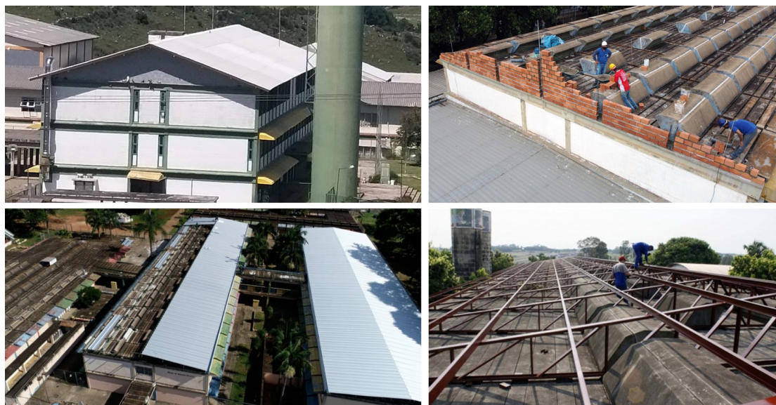
Figura 9 – Reformas no sistema de cobertura. Acima: CAIC Fúlvio Amarante Ferreira (São Joaquim-SC) – esquerda; CAIC Ricardo Monteiro (Araraquara-SP) – direita. Abaixo: CAIC Jardim Santa Terezinha II (Mogi Guaçu-SP) – esquerda; CAIC José Pedro Brum (Toledo-PR) – direita.
