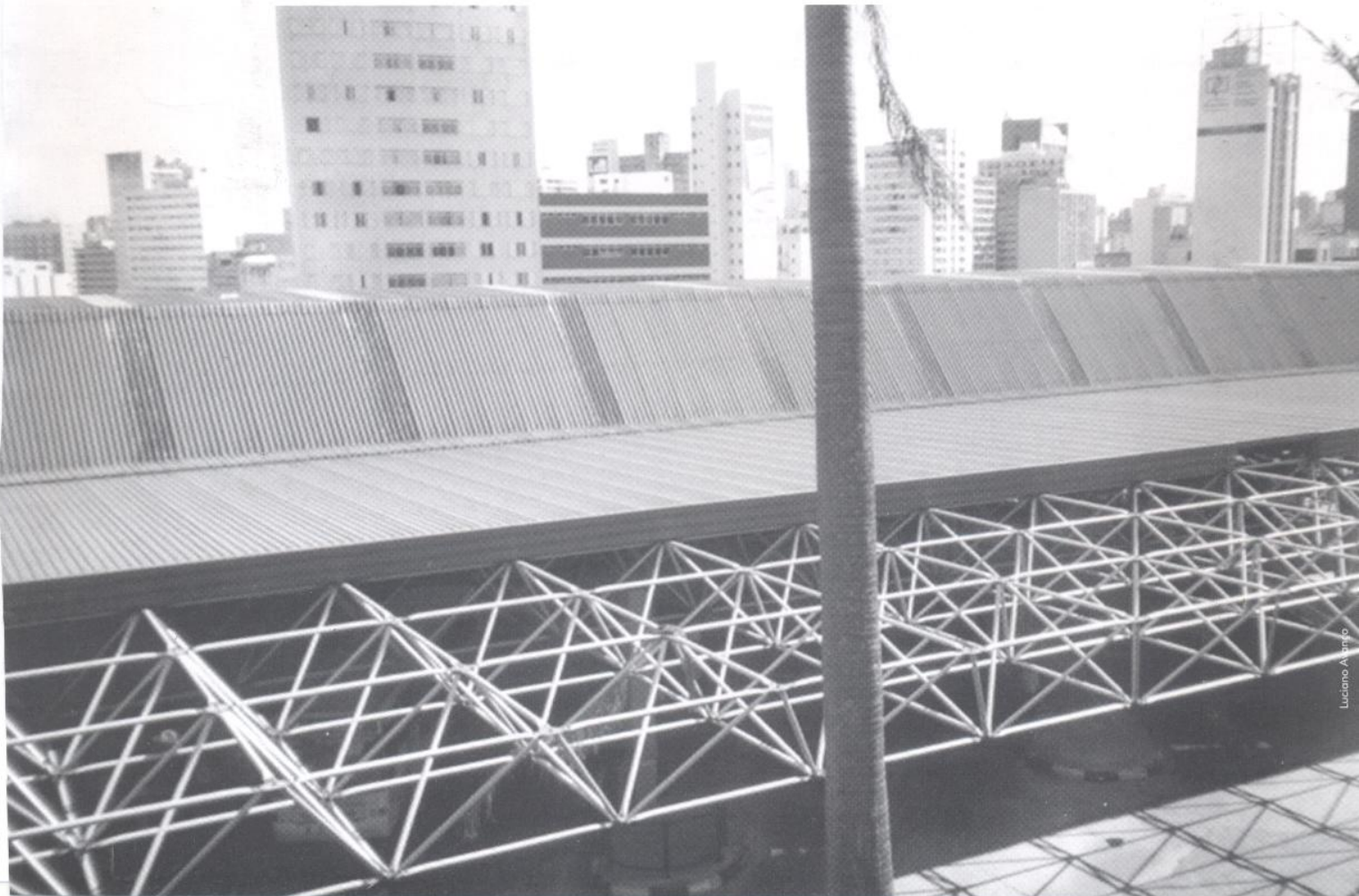
Viaduto Miguel Vicente Cury . Terminal Central 2001
