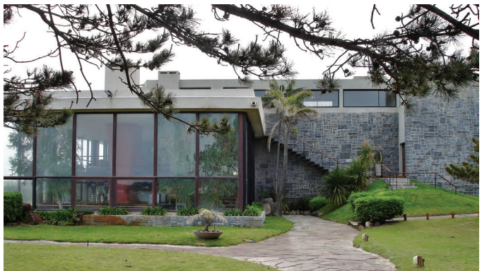
FIGURA 8 — Vista frontal após a obra de 2008.
