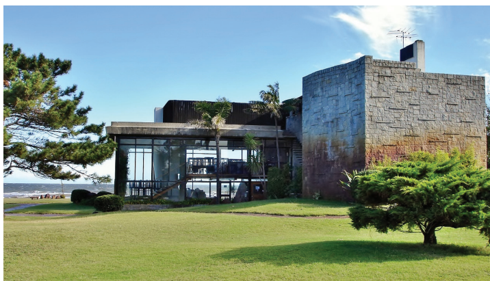
FIGURA 6 — Vista posterior antes da intervenção, com o anexo revestido em pedra. Fonte: Fotografia do autor (2006).
