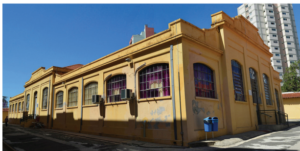
FIGURA 1 — Instituto Profissional Bento Quirino/Colégio Técnico de Campinas (COTUCA): (1) Edifício Escola e (2) Edifício das Oficinas, 2014. Fonte: Grupo de Conservação e Restauro da Arquitetura (2014).
