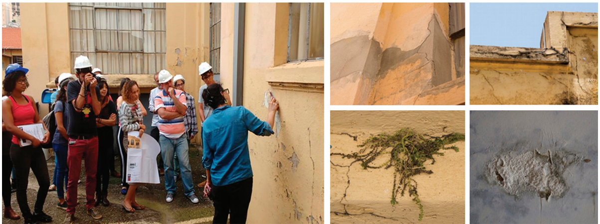
FIGURA 9 — Estudo sobre alterações e danos nos revestimentos externos. Argamassas incompatíveis, desagregação, colonização biológica.
