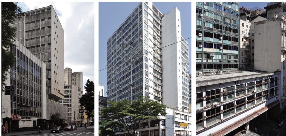
FIGURA 6 — (a) Renata S. Ferreira (Oswaldo Bratke, 1956), (b) Palácio do Comércio (Lucjan Korngold, 1954) e (c) Galeria R. Monteiro (Rino Levi, 1959). Fonte: Acervo pessoal do autor (2017).
