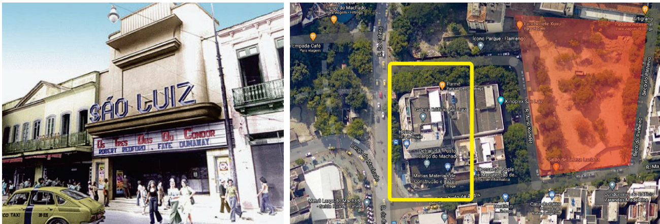
FIGURAS 7 e 8 – Antigo prédio do Cinema São Luiz (à esquerda) e novo prédio (visão de topo, à direita), que hoje se encontra no lugar no casario demolido; pode-se notar também, em vermelho, na Figura 8, o grande vazio promovido pela obra do metrô entre 1970-80.
