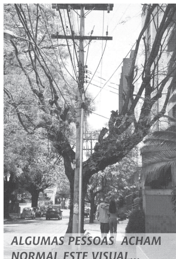
Figura 2 – Árvore mutilada pela poda, para evitar riscos na rede elétrica. Fonte: Movimento Resgate Cambuí – Campinas, SP.
