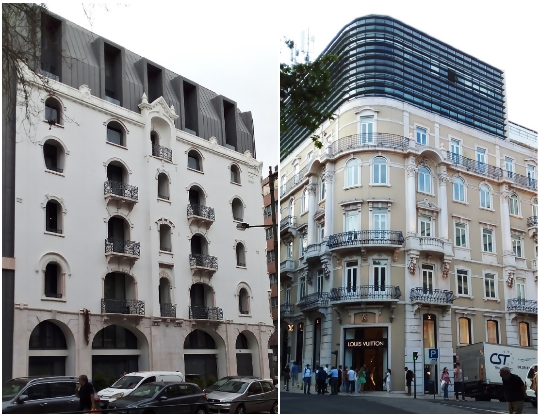
Figura 10 – Adição de pavimentos em mansarda estilizada, usual em Lisboa (esquerda); e versão contemporânea, também em Lisboa. Fonte: Arquivo do autor.
