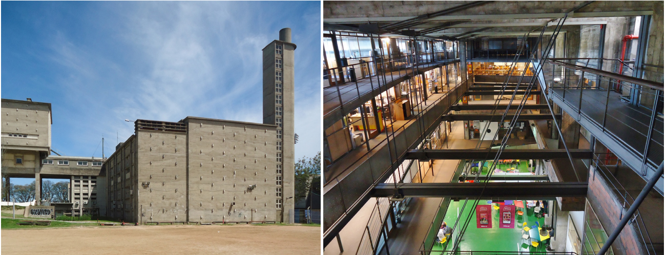
Figuras 2 e 3 – A Casa das Máquinas da Facultad de Ingeniería e suas “bandejas”.
