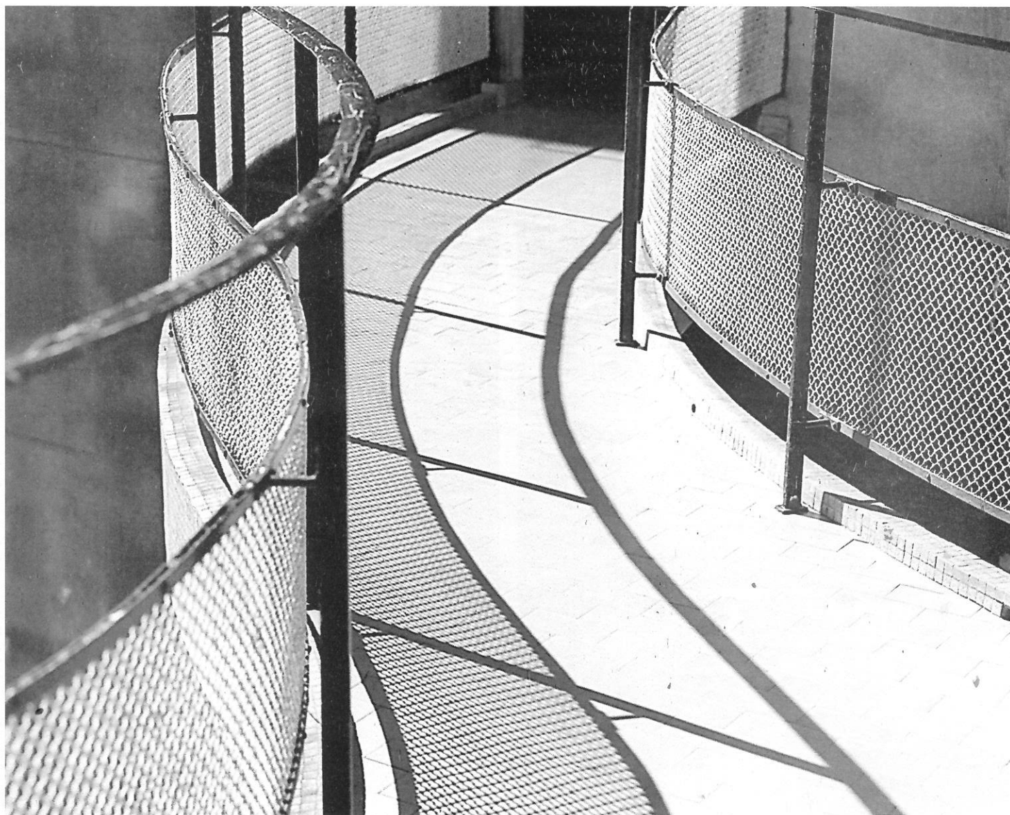
Edifício A Nacional Caixa de escada e passarela e detalhe da passarela
