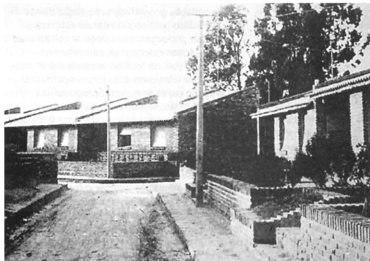
Cooperativa Exodo de Artigas 1. Espaço comum. Departamento de Rio Negro, 25 unidades, arquiteto Mario Spallanzani, 1967
