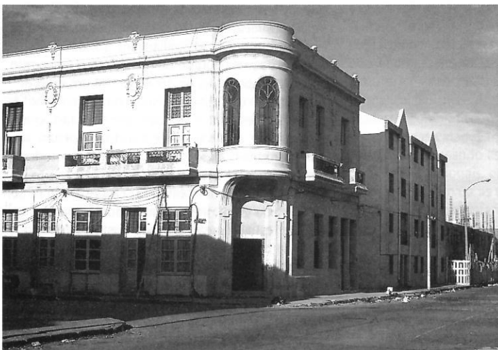
Covigoes. Reciclagem e Obra Nova, 37 unidades, equipe técnica Hacer de Sur, 1992
