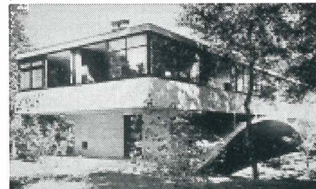
Casa-ponte do arq. Amancio Williams, modernista argentino.
